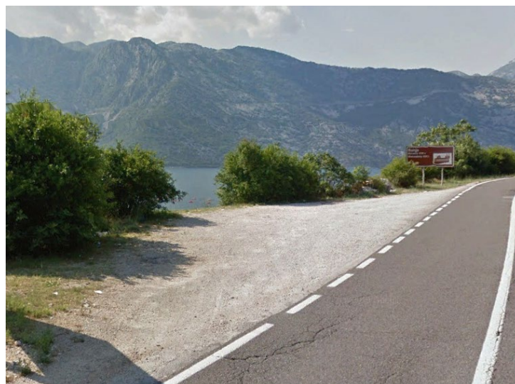
Slika 3.10. Lokacija glavne pumpne stanice PS Perast 4
