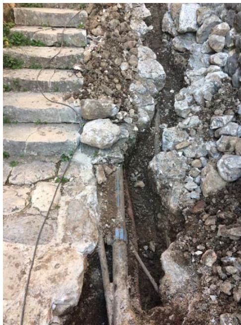
Slika 6.2. Postojeće instalacije u ručno otkopanom rovu
