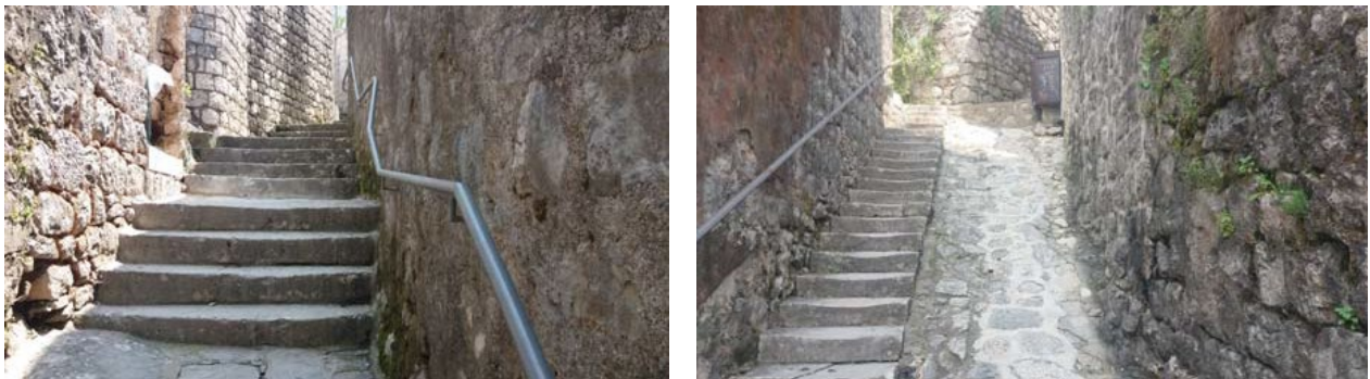
Slika 6.1. Tipične ulice punog stepenišnog profila (lijevo) i kombinovanog stepenišnog profila i plitkog kanala za odvod atmosferske vode (desno)
